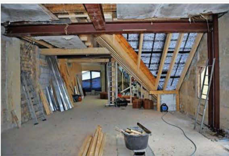
Mit dem neuen Dachstuhl entfielen die zahlreichen Stützen in den Räumen. Dafür mussten einige Stahlträger eingesetzt werden. Quelle: Enrico Kugler
