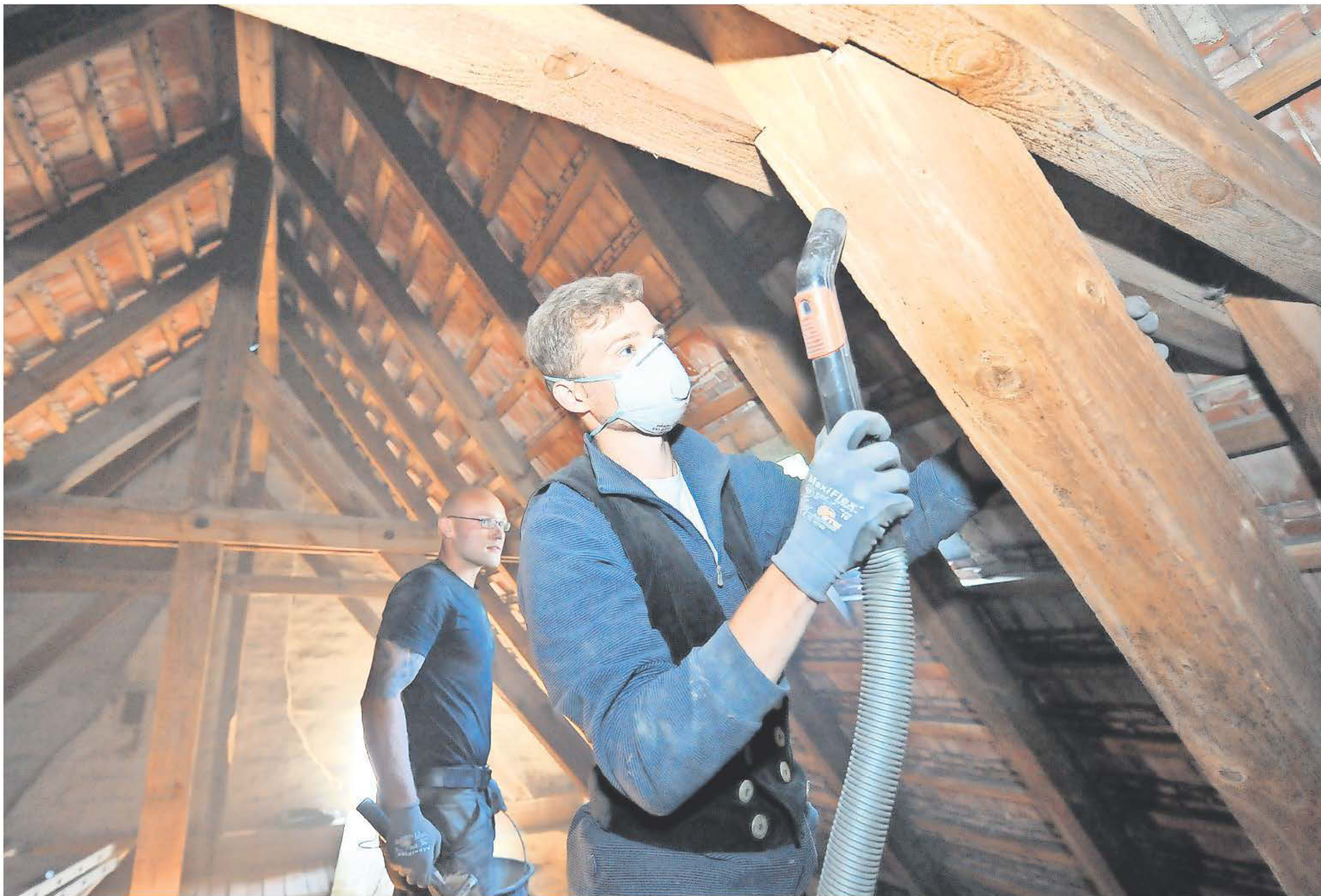
Oliver Krüger (l.) und Azubi Manuel Meier von der Zimmerei Spindler befreien die Balken vom Staub der Jahrzehnte, um sie dann mit Holzschutz behandelt zu können.
